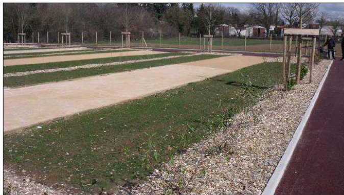
■ 170 concessions de pleine terre ont été créées pour les besoins de la quatrième tranche. Photo DR
